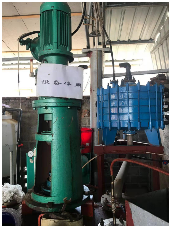
图 3-2 拆除原有合成釜设备图
