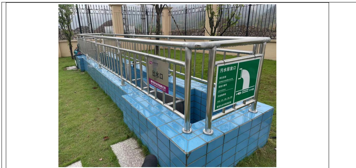
图 3-2 污水排放口出口
