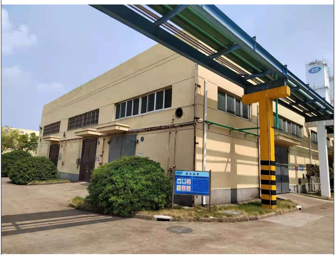
储存区 (危化品 仓库)
