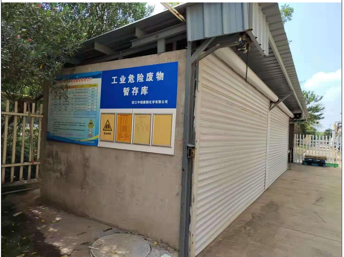
储存区 (危废暂 存间)
